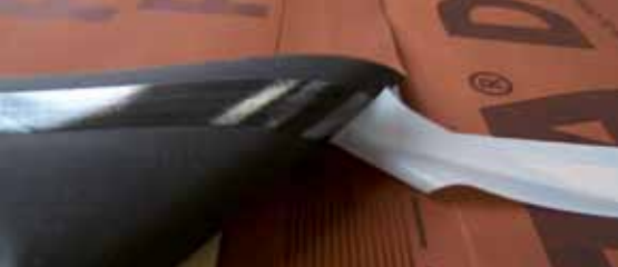
Водонепроницаемость благодаря интегрированным лентам. Уплотнение мансардного окна.
