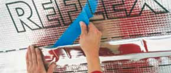
Воздухонепроницаемость благодаря интегрированной ленте.
