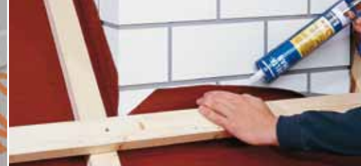
Надёжное примыкание к стенам с помощью клея DELTA®-THAN
