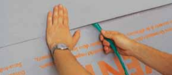
Воздухонепроницаемость благодаря интегрированным лентам
