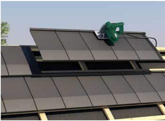
Затем кровельные панели верхнего ряда укладывают и крепят по верхнему краю на два гвоздя/самореза.
