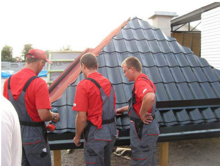
Рис. 62. Расположение планки снегоуловителя вдоль линии карниза ската
