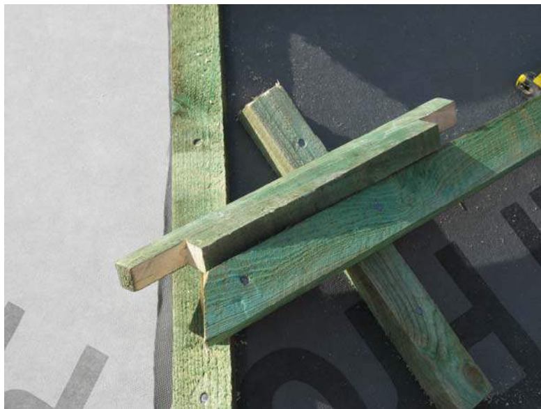
Рис.13. Шаблон для монтажа рядовых реек обрешетки
