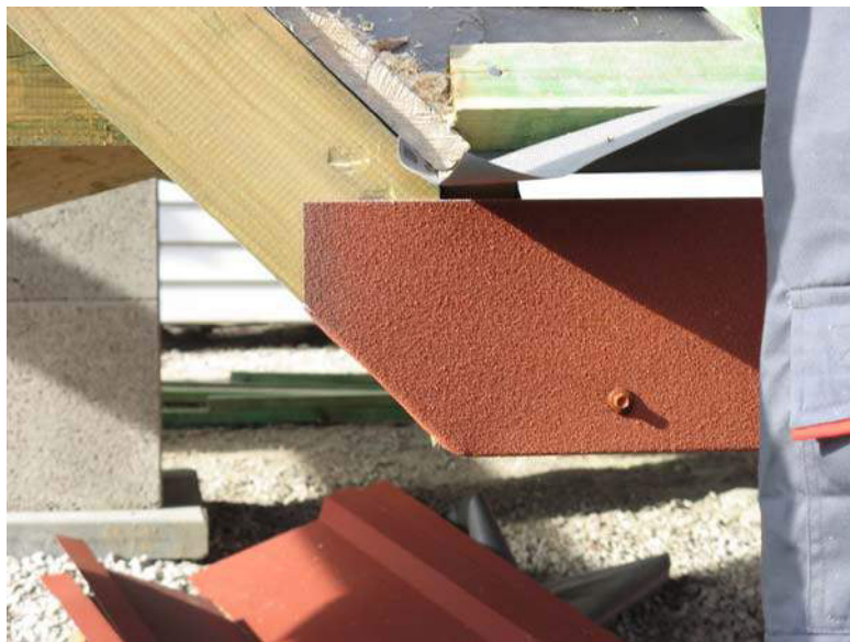
Рис.20. Размещение планки зашивки лобовой доски карниза
