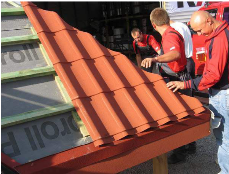
Рис.29. Окончательное закрепление первого листа металлочерепицы
