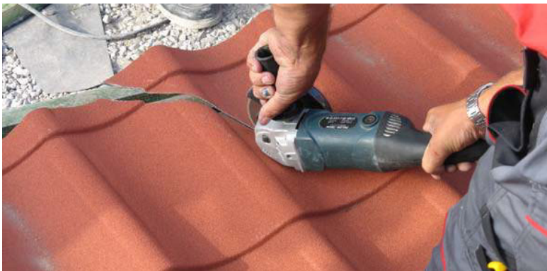
Рис.30. Подрезка второго листа металлочерепицы
