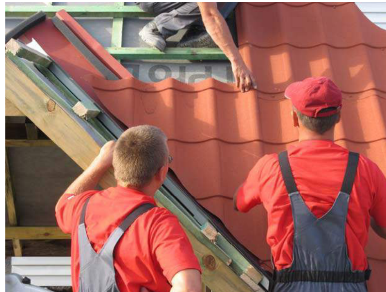
Рис.32. Монтаж третьего листа металлочерепицы
