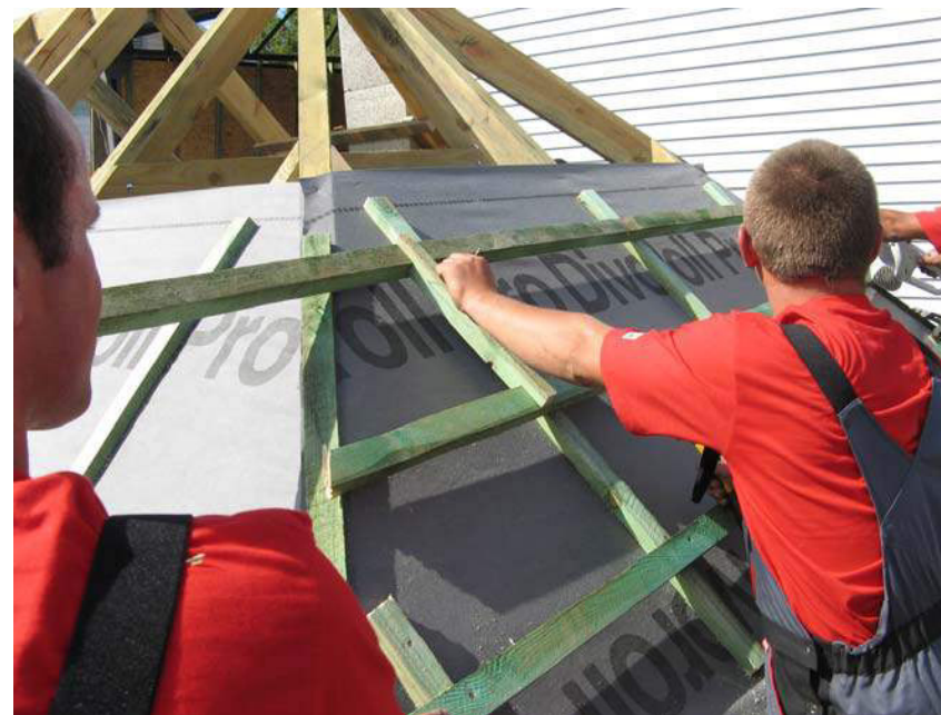
Рис.12. Монтаж рядовых реек обрешетки
