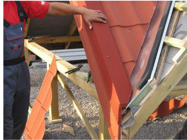
Рис.47. Монтаж планки ветрозащиты
