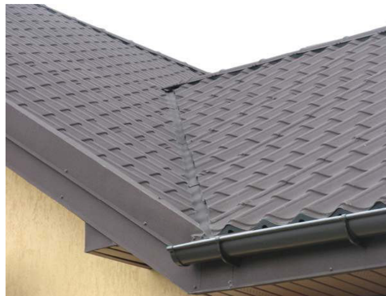
Рис. 75. Отсутствие декоративной накладки на ендове
