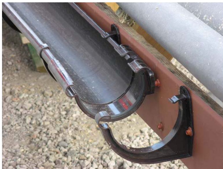
Рис. 52. Установка желобов в кронштейны
