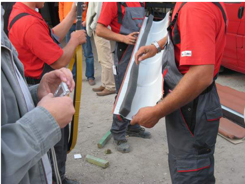
Рис.42. Наклейка универсального уплотнителя
