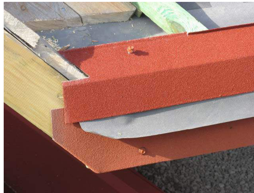
Рис.21. Размещение карнизной планки
