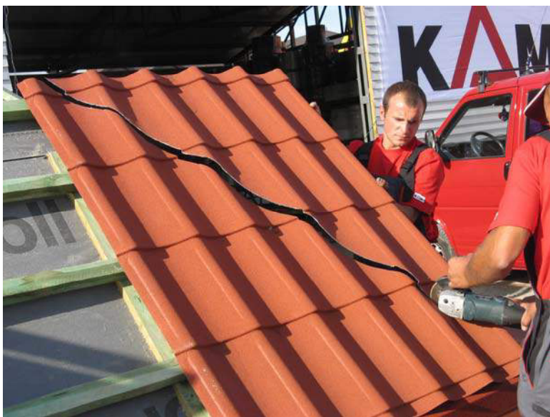
Рис.26. Подрезание первого листа металлочерепицы
