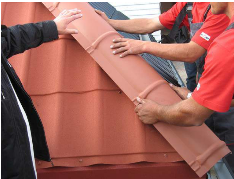
Рис.43. Монтаж планки конька
