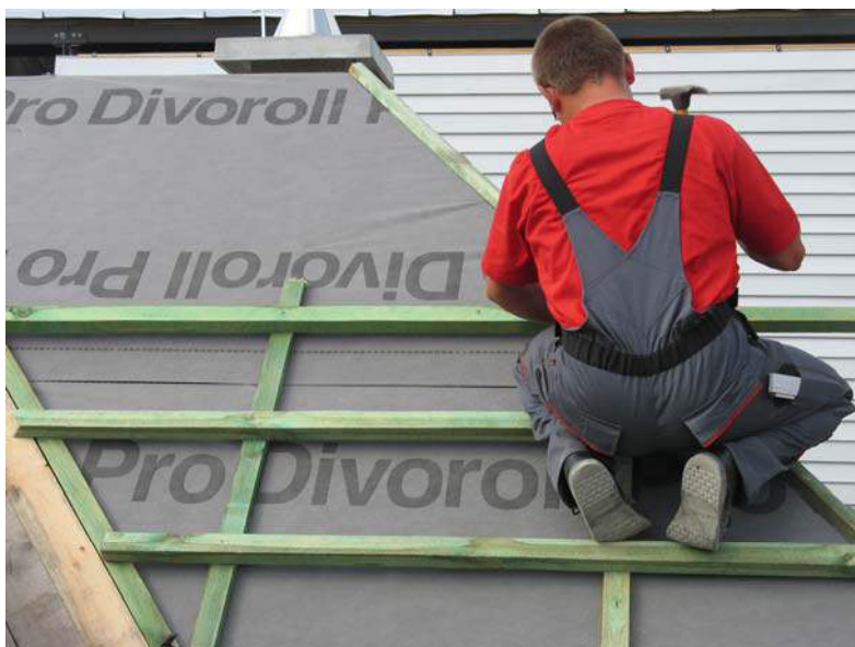
Рис.14. Расположение реек обрешетки на поверхностях скатов
