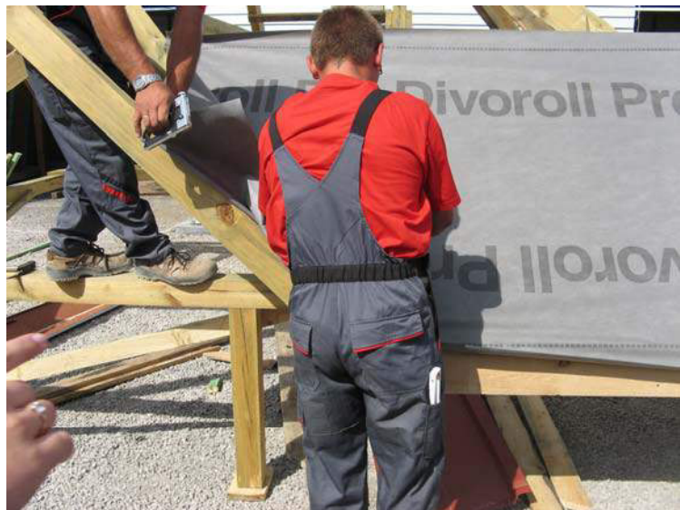
Рис.9. Раскладка полотнищ мембраны на поверхности ската
