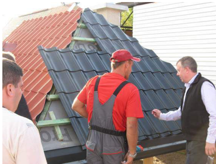
Рис.41. Расположение листов металлочерепицы на смежных скатах
