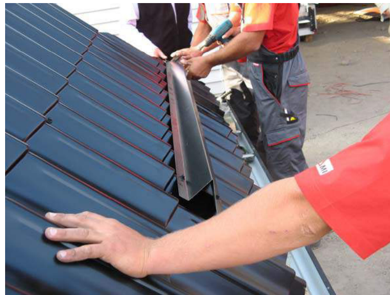
Рис. 60. Расположение планки снегоуловителя на скате
