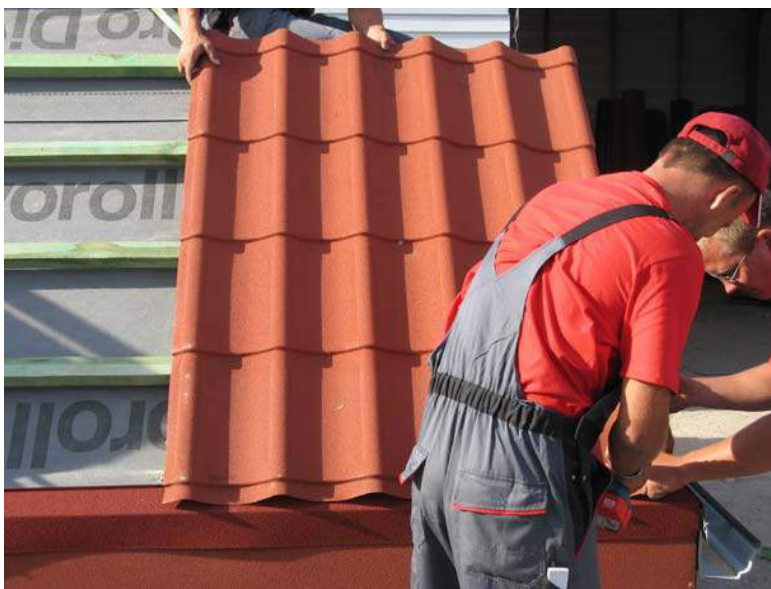
Рис.25. Монтаж первого листа металлочерепицы
