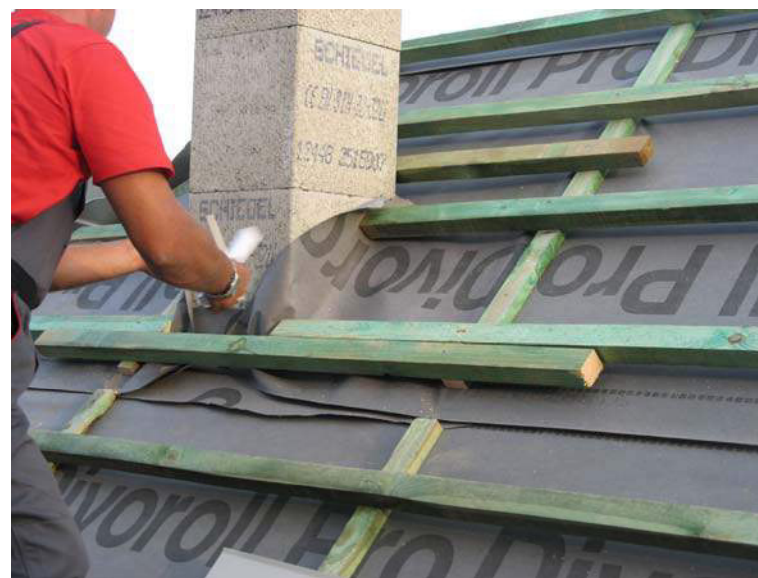
Рис. 63. Общий вид дымохода
