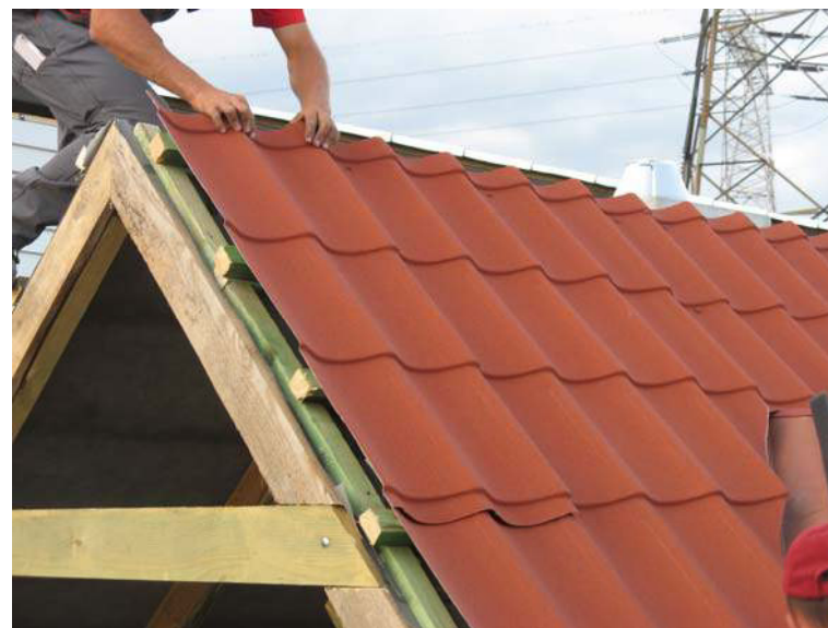
Рис.38. Окончательное крепление последнего листа на скате
