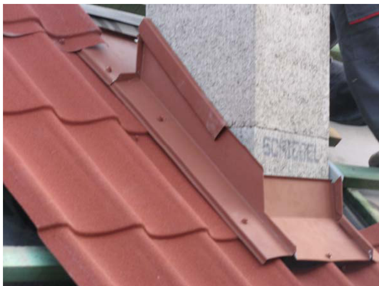
Рис. 71. Устройство защитно-декоративной полосы
