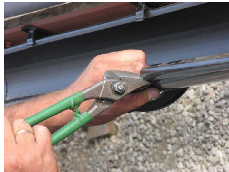
Рис. 53. Подрезание желобов
