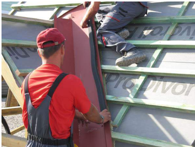
Рис.16. Устройство планки на ендове
