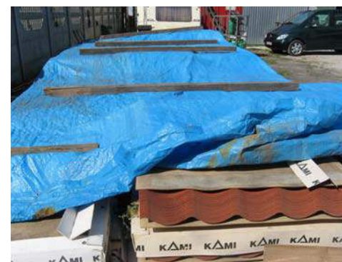
Рис.7. Хранение листов металлочерепицы на открытом воздухе
