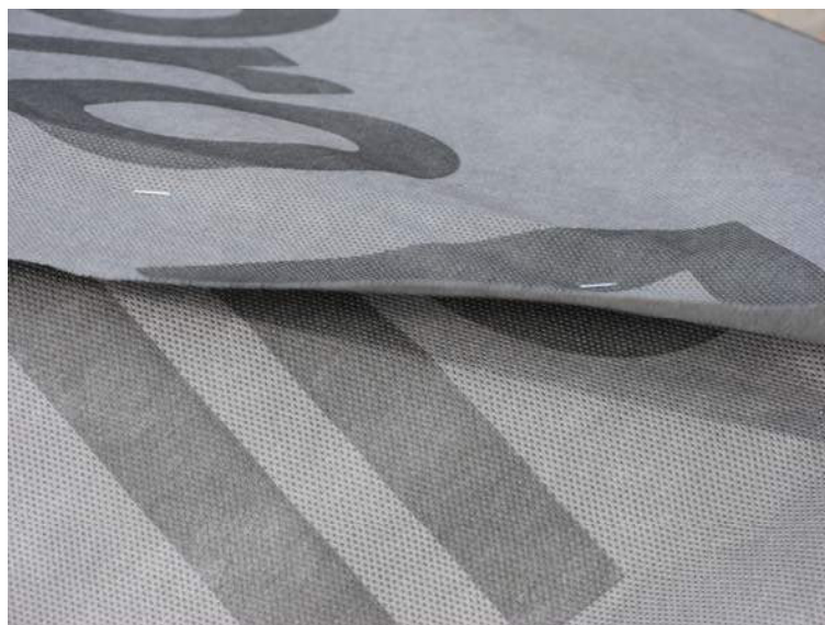
Рис.10. Соединение смежных полотнищ мембраны на стропилах
