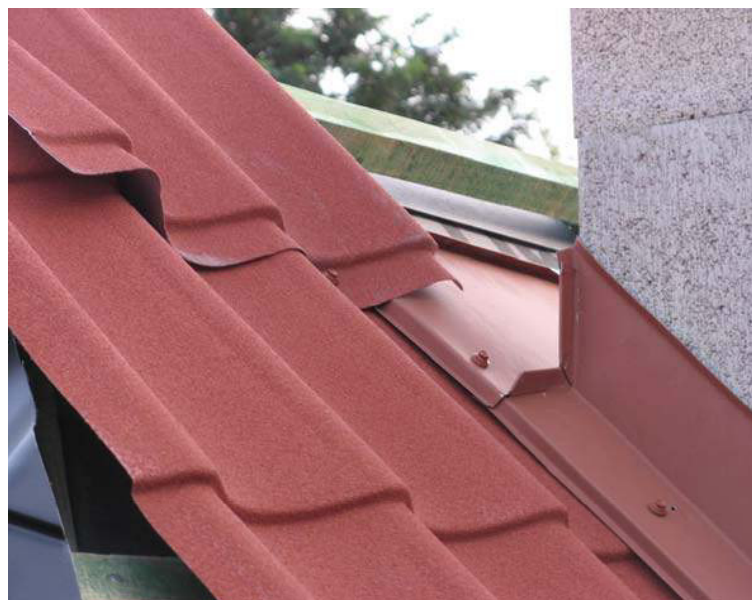
Рис. 70. Напуск металлочерепицы на верхнюю планку фартука
