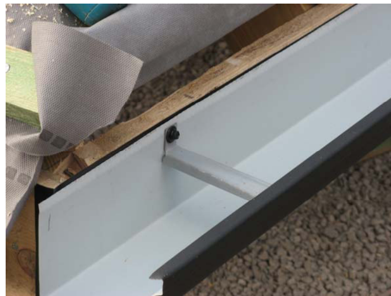
Рис. 58. Крепление планки желоба распорками
