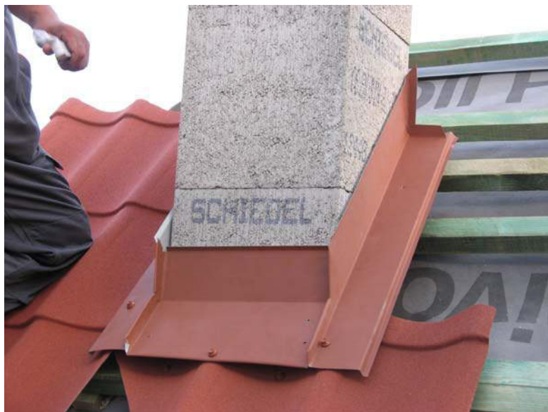
Рис. 67. Монтаж боковых планок фартука
