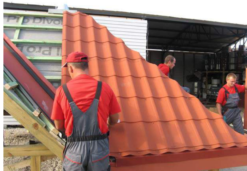
Рис.31. Монтаж второго листа металлочерепицы
