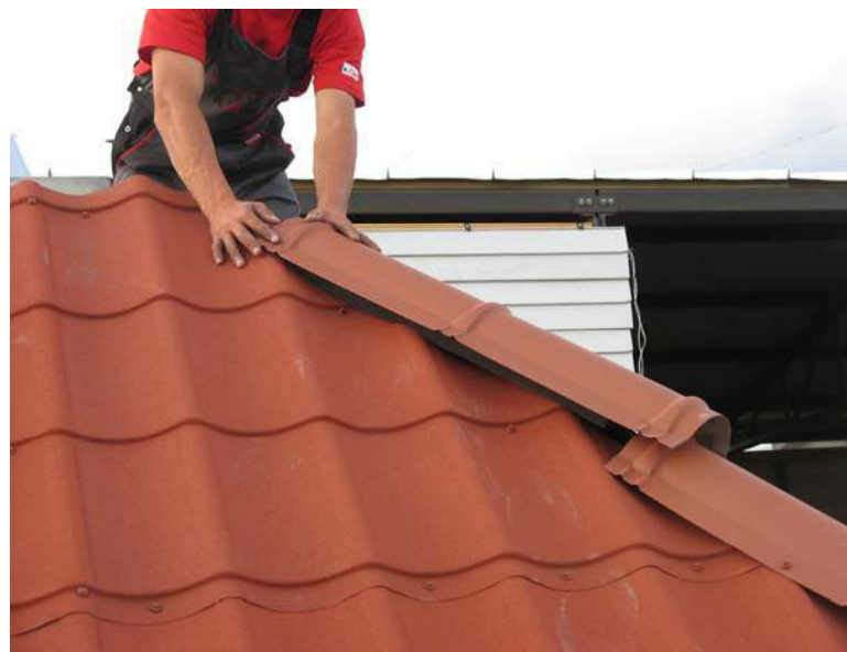
Рис.45. Монтаж смежных планок по длине конька
