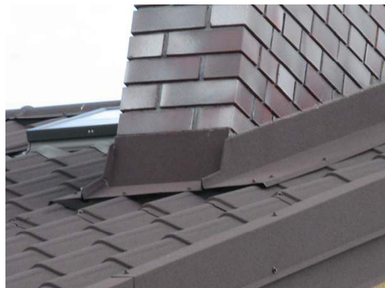
Рис. 73. Вид справа на дымоход с планками фартука
