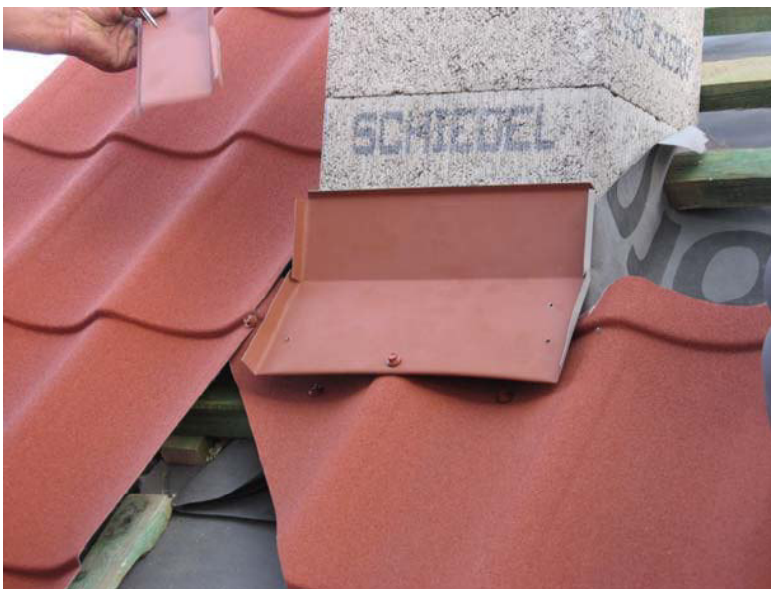
Рис. 65. Монтаж нижней планки фартука
