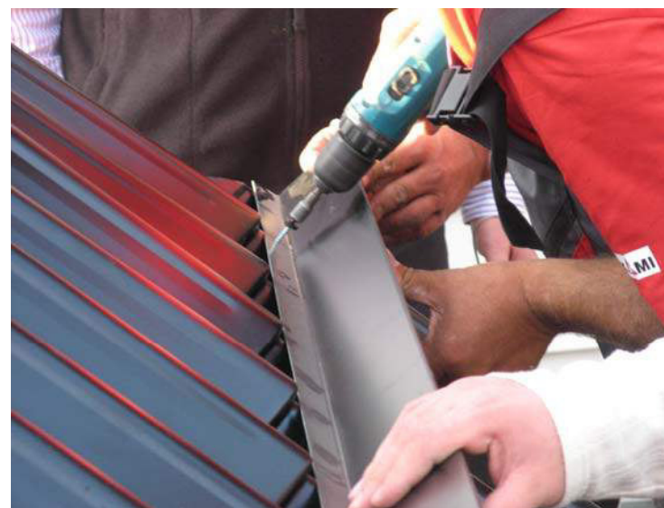
Рис. 61. Крепление планки снегоуловителя к обрешетке
