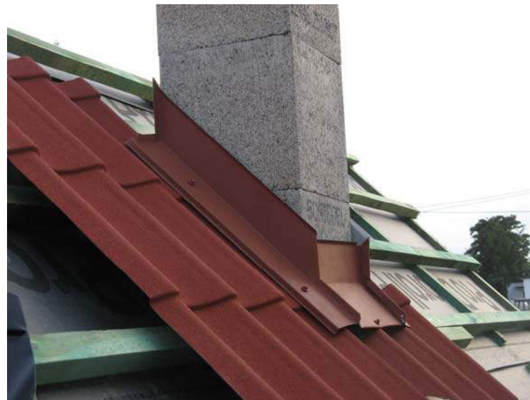
Рис. 68. Расположение боковых и нижней планок фартука
