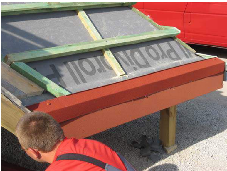
Рис.23. Расположение карнизной планки по длине карниза
