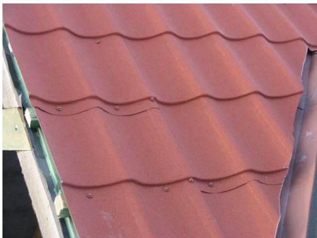
Рис.39. Обрезанные листы металлочерепицы на ендове
