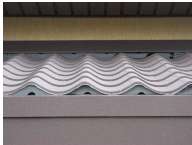
Рис. 74. Расположение уплотнителя на коньке и карнизе ската
