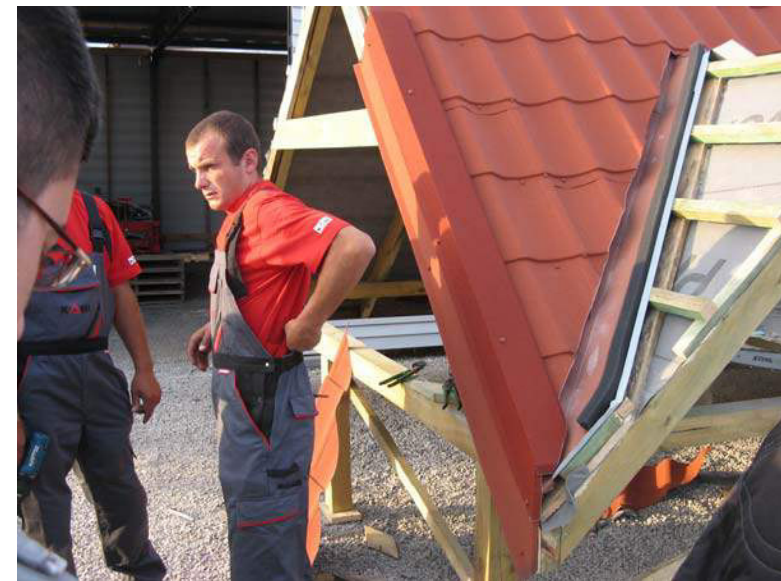
Рис.48. Крепление планки ветрозащиты к ветровой доске
