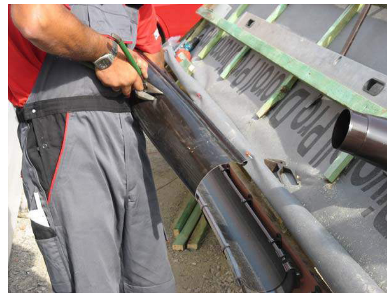
Рис. 54. Вырезание отверстия в желобе для водостока
