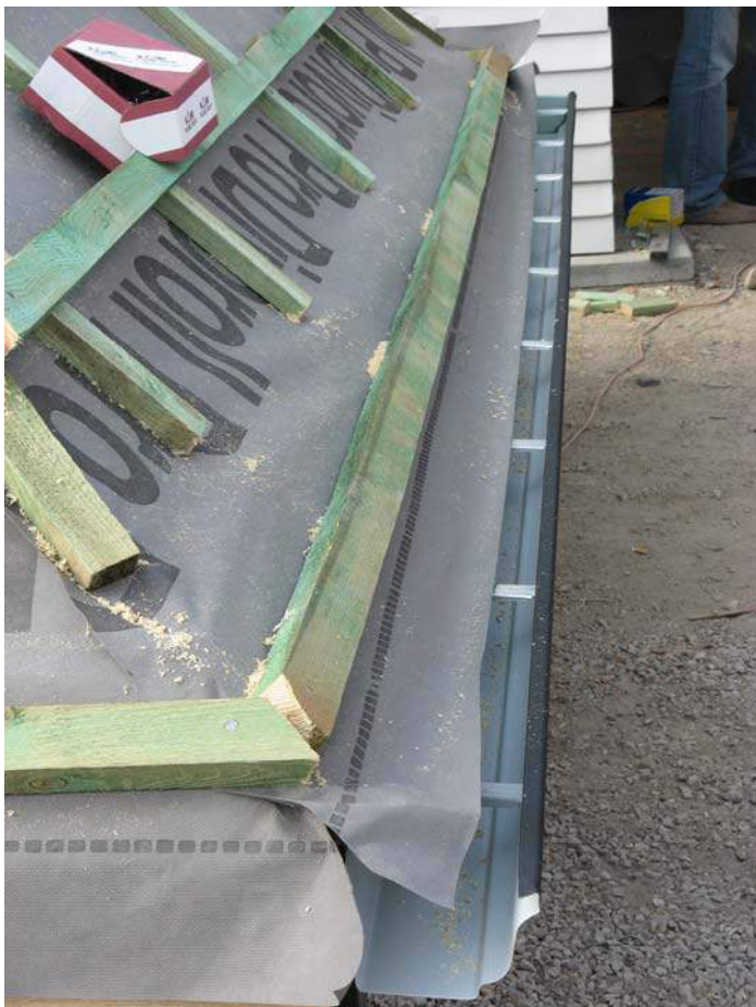
Рис. 59. Выпуск супердиффузионной мембраны в желоб
