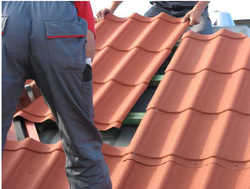
Рис.33. Укладка листа металлочерепицы в проектное положение
