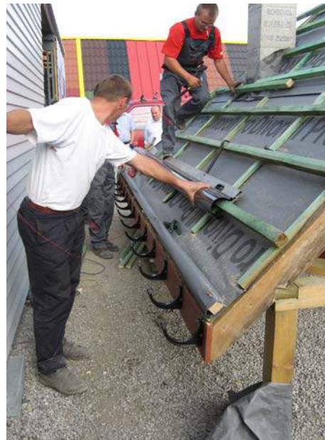
Рис. 51. Установка промежуточных кронштейнов
