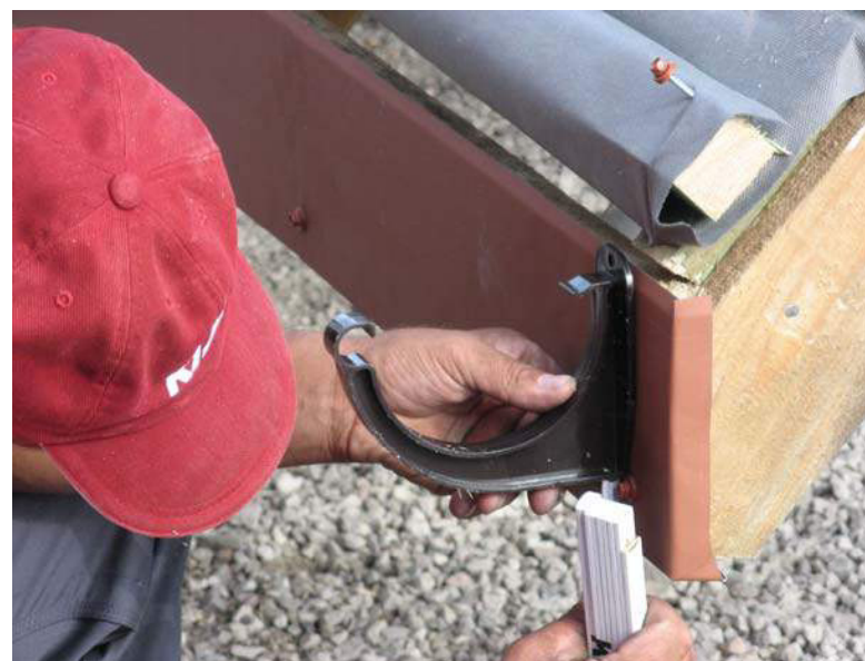
Рис. 50. Установка маяковых (крайних) кронштейнов
