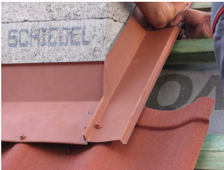
Рис. 66. Определение размеров боковой планки фартука
