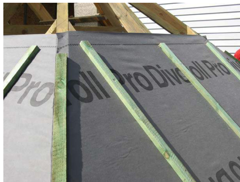
Рис.11. Устройство контрреек
