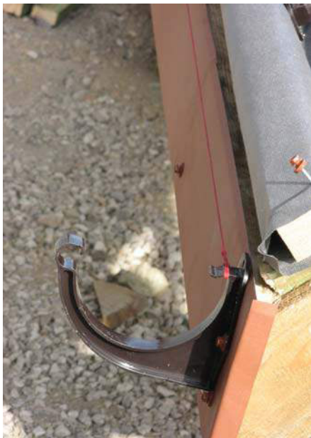
Рис. 51. Установка промежуточных кронштейнов
