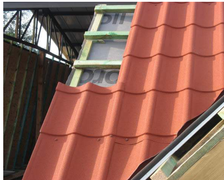
Рис.37. Проектное расположение последнего листа на скате
