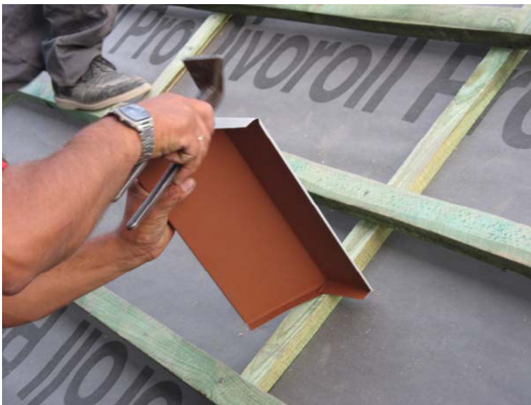
Рис. 64. Изготовление нижней планки фартука
