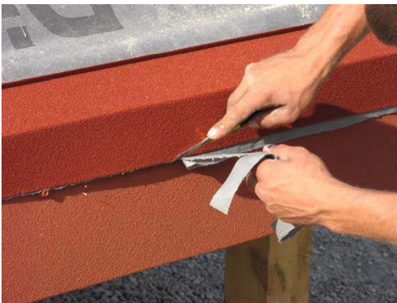
Рис.22. Подрезание краев супердиффузионной мембраны
