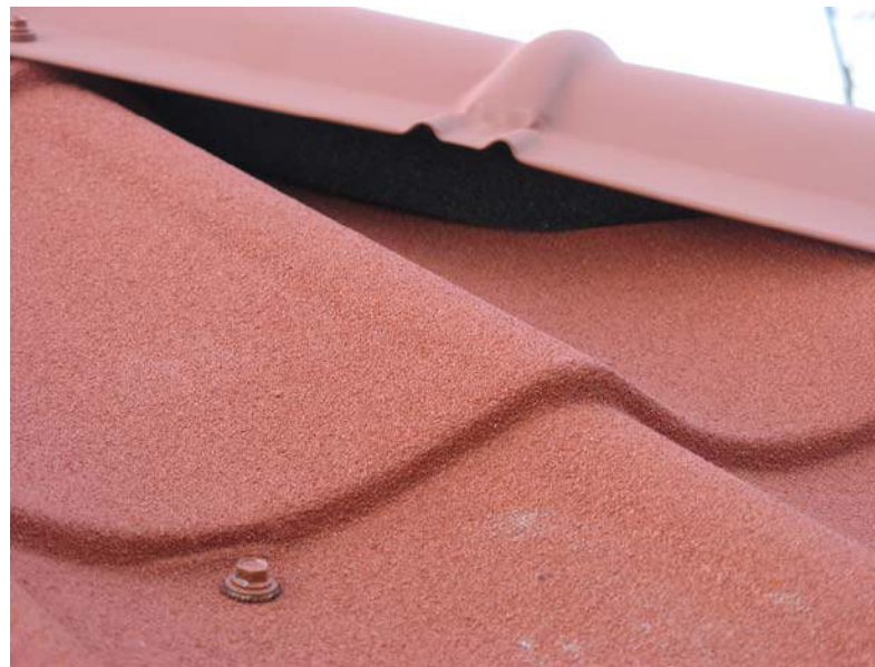
Рис.44. Герметизация подкровельного пространства возле конька
