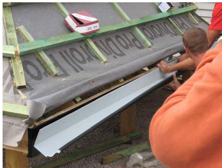
Рис. 57. Размещение планки желоба на лобовой доске
