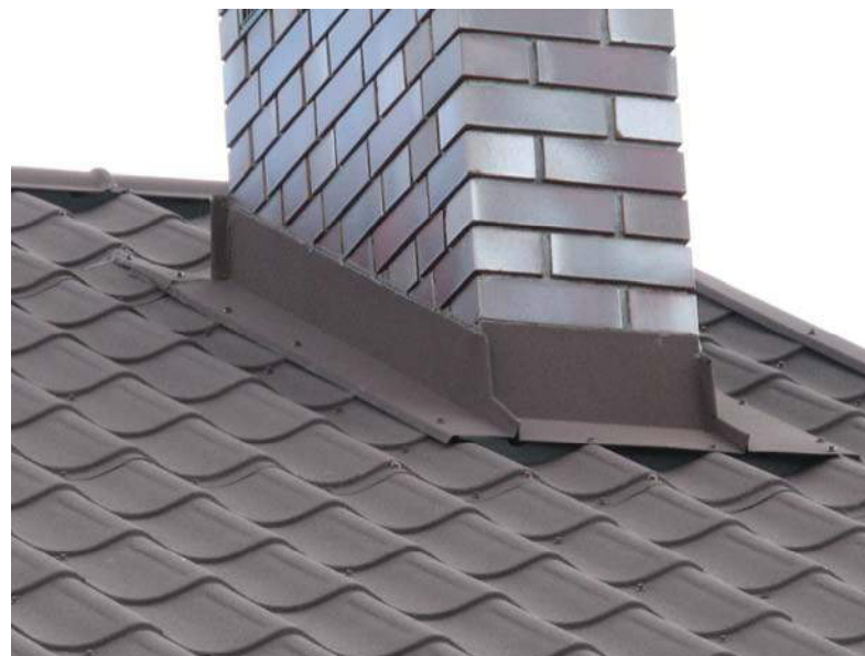
Рис. 72. Вид слева на дымоход с планками фартука
