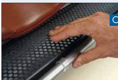
Marley Laubfrei зажимается между задней отбортовкой водосточного желоба и крепежными зажимами – готово!
