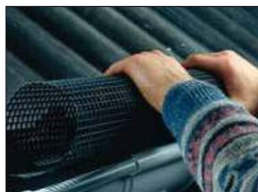
Сетчатая труба Poly-Net Laubstop укладывается в водосточный желоб и фиксируется там за счет собственной эластичности. Легко обрабатывается, так как Marley Poly-Net Laubstop поставляется длиной в 2,00 м.
