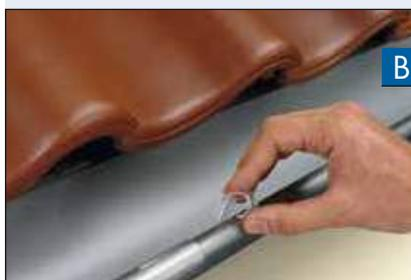
Крепежные зажимы надеваются на передний валик водосточного желоба на расстоянии в прибл. 40 см.
