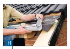
Отрезать водосточный желоб с помощью ножовки подходящей длины и уложить на опоры желоба. Заглушка просто надевается.
