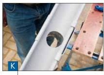
С отрезанной кромки удалить заусенцы и навесить воронку желоба на заднюю отбортовку и защелкнуть за передний валик.
