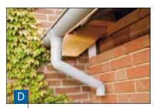
Отдельные детали системы водосточных труб просто вставляются друг в друга. В связи с достаточной глубиной вставки фасонных деталей уплотнения не требуются.
