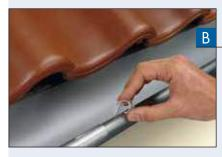
Крепежные зажимы надеваются на передний валик водосточного желоба на расстоянии в прибл. 40 см.
