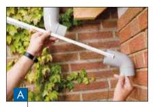
На воронку надеть колено и измерить расстояние до противоположного колена. При этом учитывать глубину вставки в 4 см и расстояние до стены дома. В случае узкого свеса крыши 2 колена соединяются непосредственно с помощью соединителя колен.
