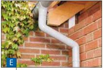
Крепление труб осуществляется с помощью хомутов, которые фиксируются на стене дома с помощью дюбелей. При этом различают "жесткие хомуты" и "свободные хомуты".
