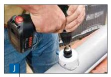
Выпиливание сливного отверстия проходит быстро и чисто с помощью кольцевого сверланасадки или с помощью пилы с мелким зубом.
