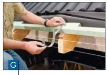
Закрепить отогнутые опоры желоба в углублениях на рейке обрешетки с помощью самонарезающих винтов или соответствующих гвоздей.
