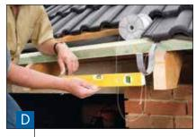
Еще раз проверить на строительном шнуре уклон, на 10 м водосточного желоба необходимо заложить 2 - 3 см уклона.
