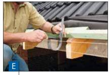
Остальные опоры желоба выставить по этому строительному шнуру, определить размер для для отгибания отдельных опор желоба и отметить на опорах желоба.
