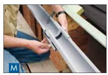
Соединительная подкладка сначала надевается на заднюю сторону соединяемых желобов, затем нащёлкивается её передняя часть на желоба. Учитывайте маркировку – система выступ-паз
