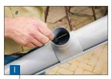
Надеть воронку, определить точное место для слива и отметить выемку для слива воды.
