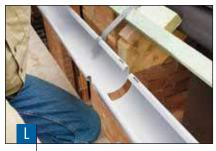
Желоба соединяются с помощью соединительной подкладки. Правильное расстояние между концами желобов получается из маркировок на соединительной подкладке.
