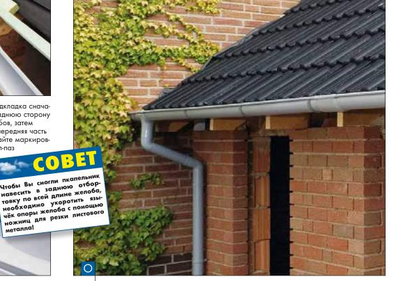
Капельники обеспечивают дополнительную защиту от дождевой воды и заносимого снега. Они навешиваются в отбортовку водосточного желоба и крепятся кровельными винтами к рейке обрешетки.
