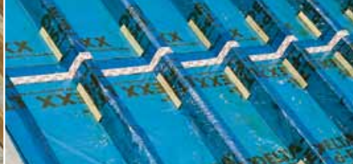
После монтируется DELTA®-Sd-FLEX.
