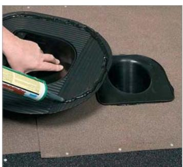
4. Прижать адаптер к кровле. Промазать фланец вентиля резино-битумом.
