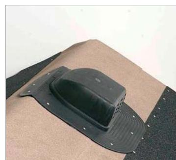
5b). При монтаже на конек: перегнуть фланец через конек, прибить гвоздями.
