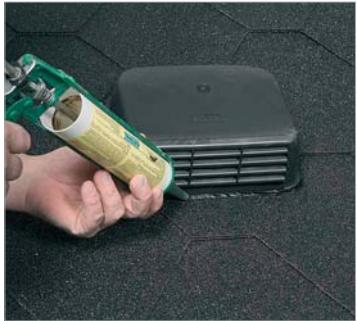
6. Вырезать и установить плитку вплотную в вентилю. Промазать место стыка резино-битумом.
