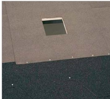
2. Вырезать в кровле отверстие 170 мм x 170 мм.
